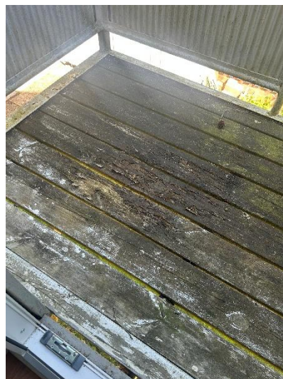
Balkongen är i renoveringsbehov, rötskadade golvbrädor.
