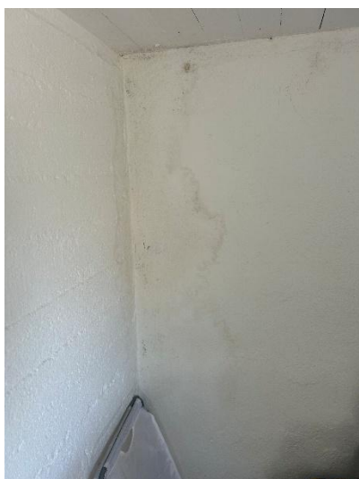
Fuktgenomslag missfärgning på yttervägg i tvättstugan. Delvis med högre och höga fuktvärden. 16,8% och 99,9%.
