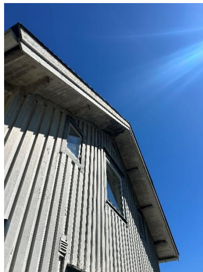
Underhåll/målning och mindre lokala rötskador noterades på takutsprången.
