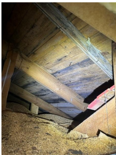
Mikrobiellpåväxt förekommer på underlagstaket på bådanockvindarna.
