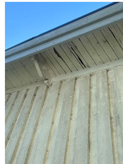
Underhåll/målning och mindre lokala rötskador noterades på takutsprången.
