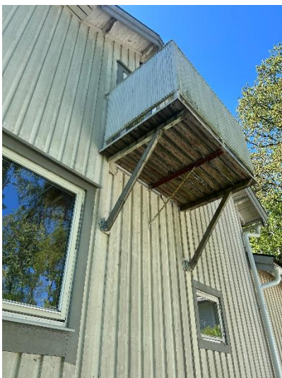
Balkongen är i renoveringsbehov, rötskadade golvbrädor.
