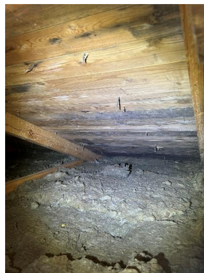
Mikrobiellpåväxt förekommer på underlagstaket på bådanockvindarna.
