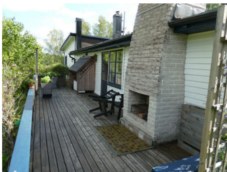
Fasader och fönster
