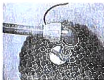
Fig 7. Vattenpumpens placering mitt i ProACT®-tankens inre tank
