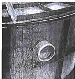
Fig 2. Inkommande rör till ProACT® från huset görs med standard 110 mm avloppsrör. OBS: Vrid ej inloppsröret i tanken
