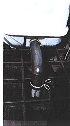
Fig 10. Gummiröret från pumpen säkras med medföljande klämmor
