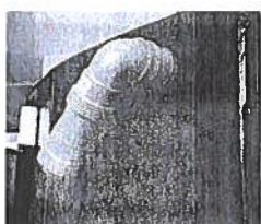
Fig 4. Inloppet till InterACT® är anpassat för 40 mm PEM-slang. Kör in slangens hela vägen fram till böjen.
