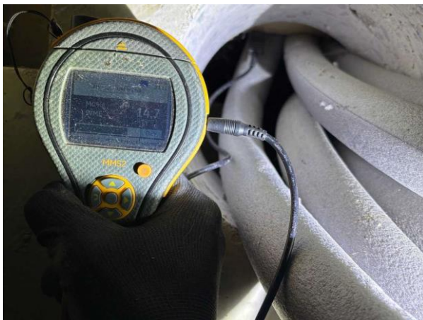
Bild 2: Utvändigt, Grund, Inga förhöjda fuktvärden noterades på golvregel under tillbyggnaden.
