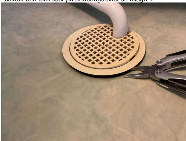
Bild 9: Invändigt, Entréplan, Badrum, Äldre våtrum Klämringen i golvbrunnen är lös
